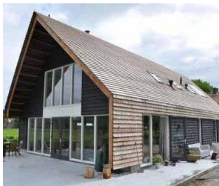
Biobased bouwen. houten woonhuis (Orga architecten)
