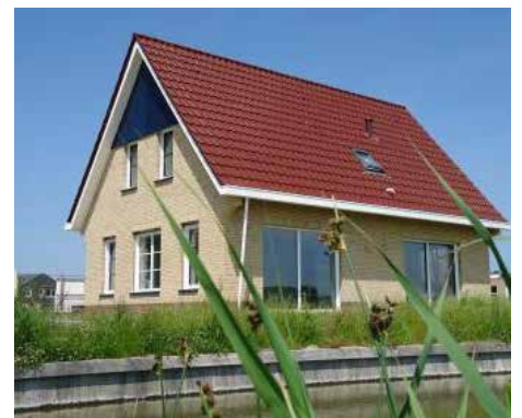
Passief bouwen, woonhuis Witmarsum (Plannon Woningbouw)
